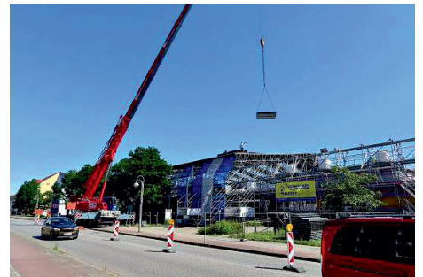
Ein Kran hebt Bauteile vom Dach des Vereinshauses „Kosmonaut“. FOTO: EVA-MARTINA WEYER
